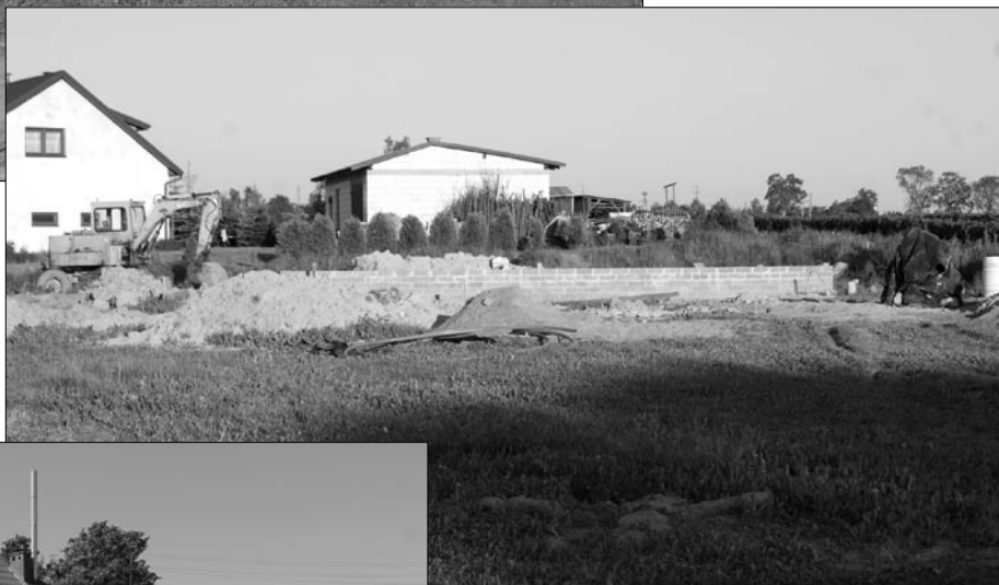
Budowa świetlicy wiejskiej w Klikawie
