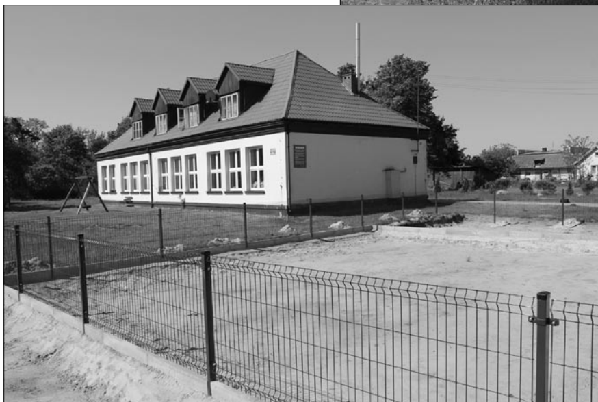
Budowa placu zabaw w Wólce Gołębskiej
