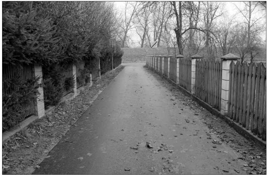
Fragment nowej nawierzchni asfaltowej na ul. Podwale w Górze Puławskiej.
