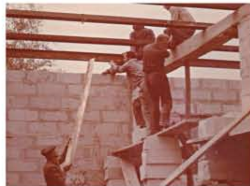
Budowa nowej strażnicy OSP Łęka - szalowanie stropu w sali (1979 r.).
