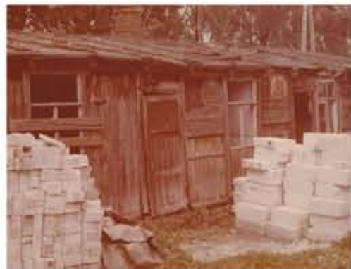
Materiał budowlany, zgromadzony na budowę nowej strażnicy.
