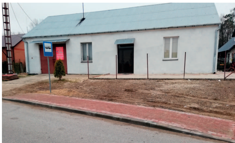
Budowa infrastruktury komunikacyjnej w ciągu dróg gminnych na terenie gminy Puławy.
