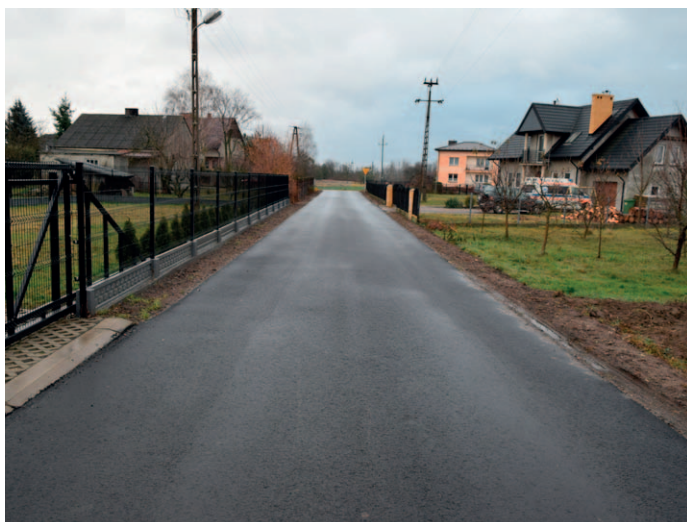
Przebudowa drogi gminnej – ul. Bocznej w Gołębiu na odcinku 141,3 m.
