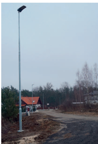
Budowa oświetlenia drogowego w Górze Puławskiej.
