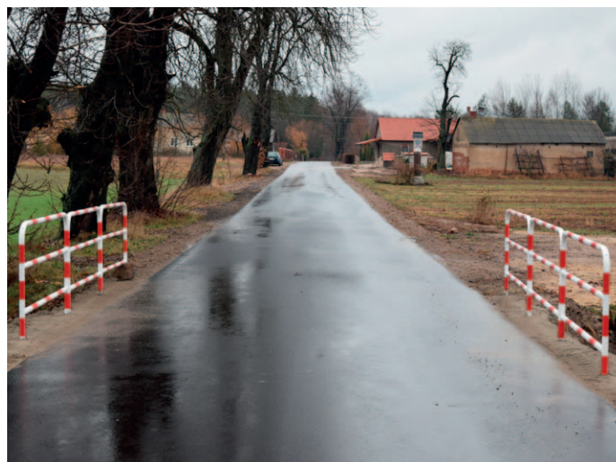
Przebudowa drogi gminnej w Piskorowie na odcinku 411 m.
