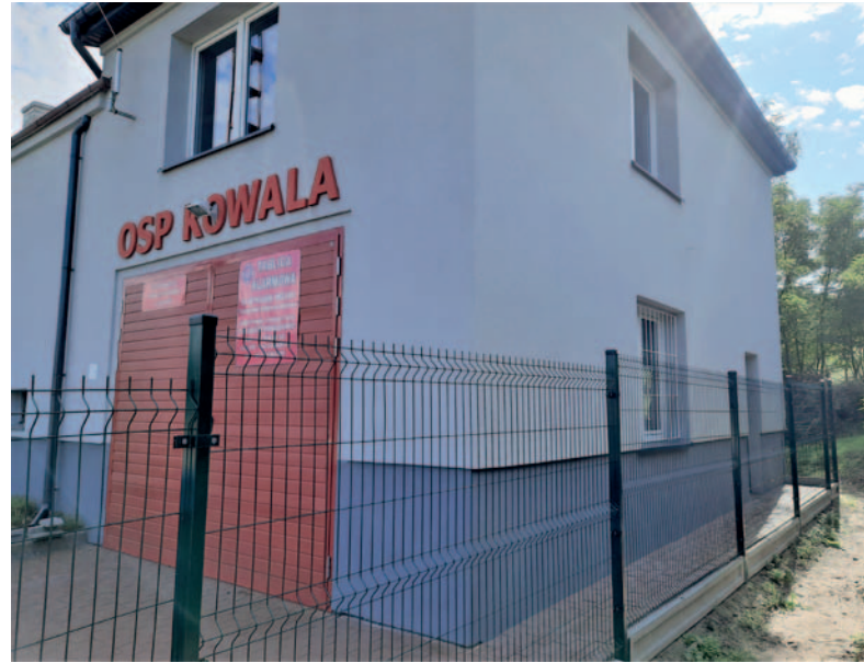
Termomodernizacja budynku OSP Kowala, koszt: 23 486,52 zł
